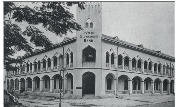
Gebäude der Deutsch-Ostafrikanischen Bank in Dar-es-Salam (9)
